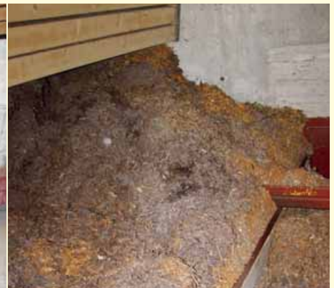
Foto 2 Deposito della biomassa di capacità pari a 120 m 3 . La biomassa è costituita da una miscela di cippato di vite e pino nero con contenuto idrico medio del 35%
