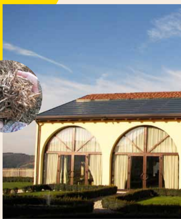
6. L'impianto FV (12,5 kWp) installato sul tetto dell'agriturismo e il cippato di vite usato in caldaia (5.)
